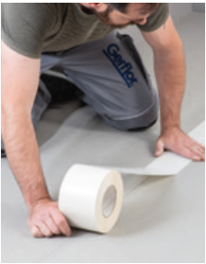
2. Poser la bande de maintien hop & positionner les lés
